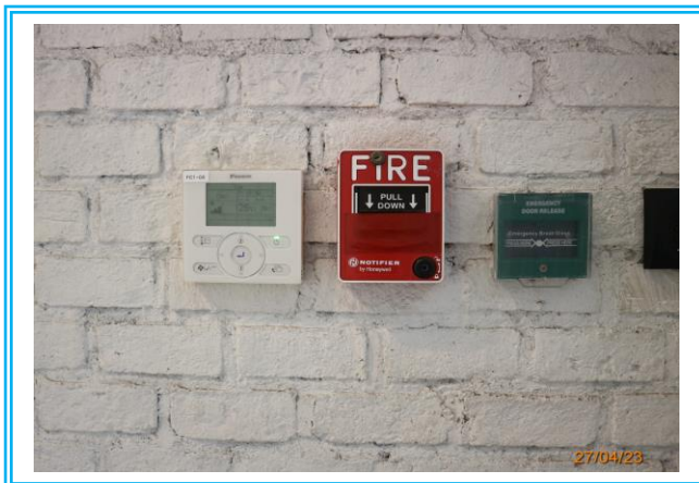
รูปที่ 3-38 อุปกรณ์แจ้งเหตุเพลิงไหม้แบบใช้มือ
