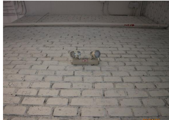
รูปที่ 2.9-8 ไฟส่องสว่างฉุกเฉิน (Emergency Light)
