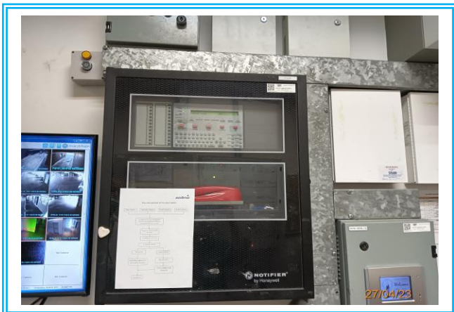
รูปที่ 3-37 Fire Alarm Control Panel ห้องควบคุม
