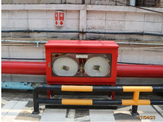
รูปที่ 2.9-5 ตู้เก็บสายฉีดน้ำดับเพลิงพร้อมอุปกรณ์
