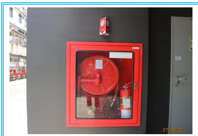
รูปที่ 3-40 ตู้เก็บสายน้ำดับเพลิงพร้อมอุปกรณ์
