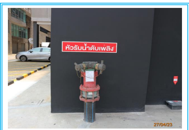
รูปที่ 3-41 หัวรับน้ำดับเพลิงภายนอกอาคาร
