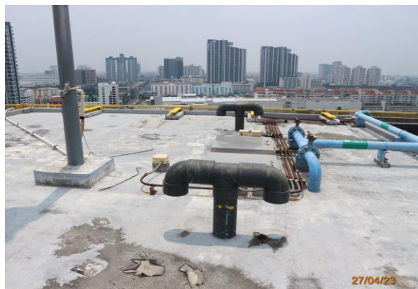
รูปที่ 3-12 ท่อระบายอากาศ
