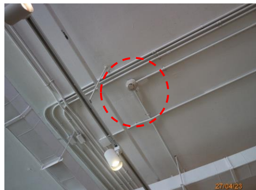
รูปที่ 2.9-2 Smoke Detector
